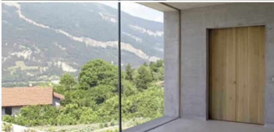
dichten, auf denen die hervorragenden Wärmedämmeigenschaften basieren. Damit kann Liapor-Isolationsbeton dann auch ein niedriges spezifisches Gewicht von weniger als  $1.000 \text{ kg/m}^3$  erzielen. Die gleichzeitig optimale Kornfestigkeit von Liapor und die hohe Druckfestigkeit des Blähglasgranulats bilden die beste Voraussetzung für eine vielseitige Anwendung im Bausektor: vom Zuschlagstoff für Leichtbeton, Mörtel und Putze bis hin zu Schüttungen.
