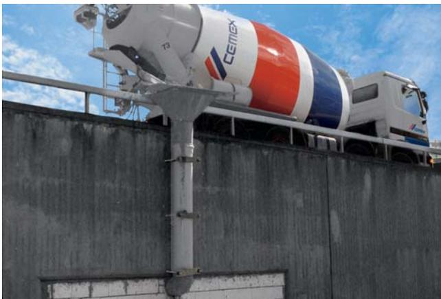
füma® gelangt einbaufertig mittels Fahrmischer auf die Baustelle und ist direkt verarbeitbar.
