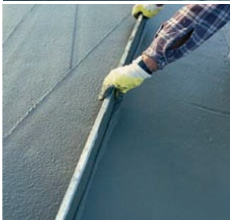
Herstellung eines Gefälles mit estritherm®: Abziehen der Oberfläche
