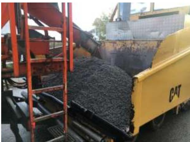
*Der Fahrmischer liefert den Dränbeton Pervia® direkt zum Einbauort.*
